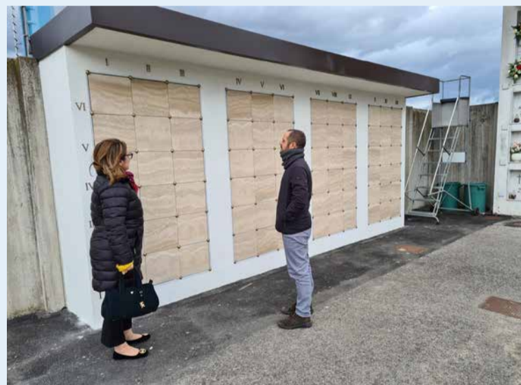
La vice sindaca Michela Mussoni e l'assessore Filippo Borghesi in un sopralluogo a conclusione dei lavori al cimitero di Sant'Ermite
