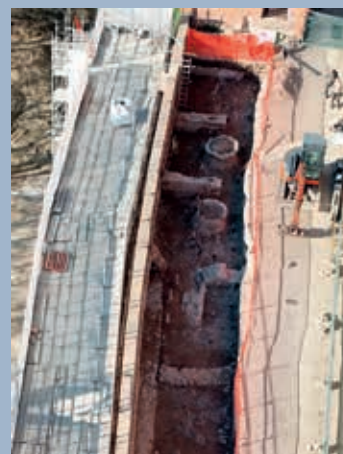
Il cantiere di via Pio Massani
